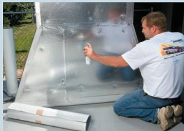
*Todas las superficies deben estar limpias, secas y cálidas. Utilice el MFM Low-VOC Spray Adhesive™ para mejorar la adherencia en áreas sombreadas, en la parte inferior de los conductos y en temperaturas frescas.*
