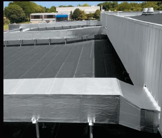
*En los sistemas rectos de gran longitud, FlexClad® produce una apariencia limpia y despejada. Dado que se instala de forma rápida y sencilla, reemplaza el costoso y engorroso aislante metálico que se utiliza comúnmente para proteger los conductos aislados.*
