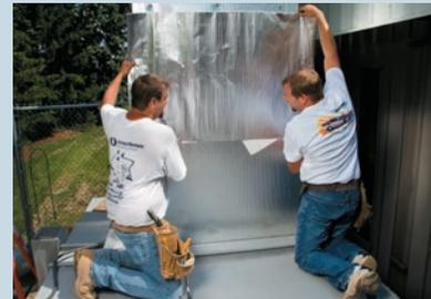
*Corte la sección siguiente a su tamaño. Superposición de al menos 7 cm para poder crear una junta impermeable.*
