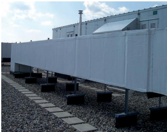
*Si se aplica correctamente, FlexClad® crea una barrera protectora contra las inclemencias del tiempo, y la superficie de aluminio resistente a los rayos UV refleja la luz del sol para reducir la temperatura interior y los costos energéticos. Dado que es duradero, protector y autosellables alrededor de perforaciones, se ajusta y sella eficazmente alrededor de los soportes de apoyo externos.*
