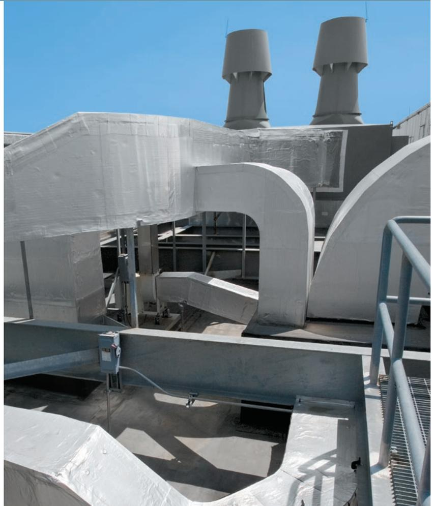
*FlexClad® prácticamente se puede aplicar a cualquier forma o configuración. Protege completamente los conductos de la infiltración de humedad exterior y la perjudicial luz del sol, y cuenta con una garantía de 10 años de MFM.*
