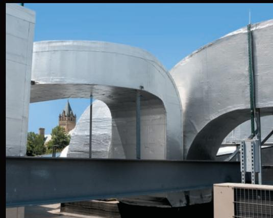
*Las instalaciones potencialmente complicadas que incluye el revestimiento de esquinas redondeadas y formas extrañas se realizan fácilmente con FlexClad® y sus excelentes características de alargamiento se ajustan al movimiento de la estructura.*
