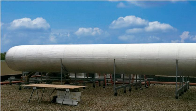
*La superficie de aluminio es una película laminada extremadamente durable que es altamente resistente al rasgado y a la perforación. La flexibilidad de FlexClad® permite que la membrana se adapte a formas curvas como esta gran tubería de suministro de agua para mantener una temperatura fresca cuando la temperatura es elevada y cálida en los períodos más fríos.*
