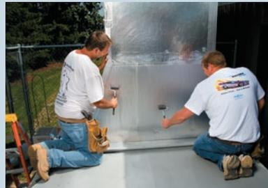
*Complete la instalación mediante la aplicación de presión firme en toda la superficie con un rodillo de mano.*
