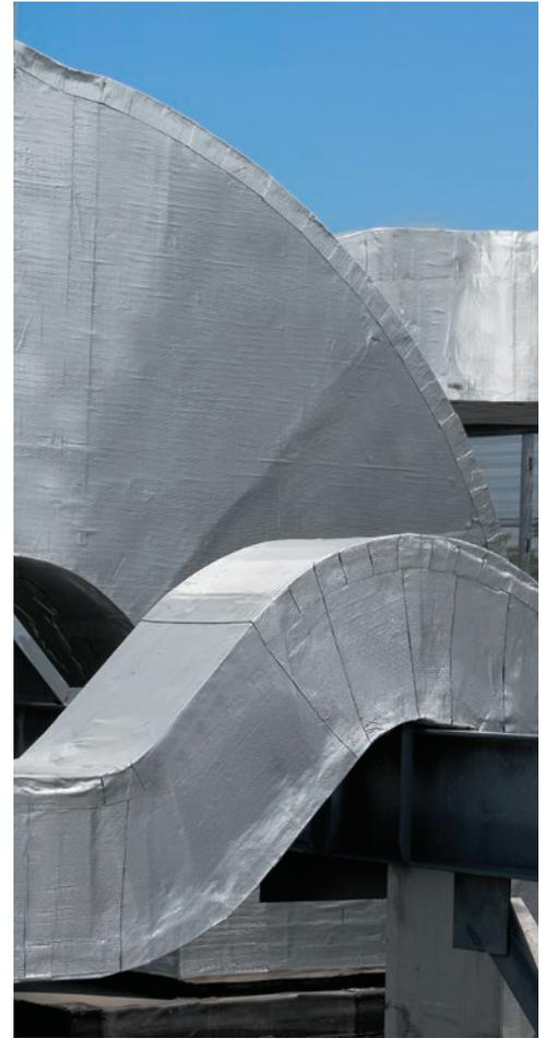
*Cuente con el adhesivo de asfalto goma altamente agresivo de FlexClad® para que se adhiera al aislante rígido y lo proteja de las inclemencias del tiempo y el deterioro.*
